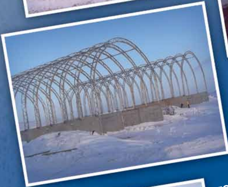
FONDATION POUR DÔME D'ENTREPOSAGE, SCHEFFERVILLE
