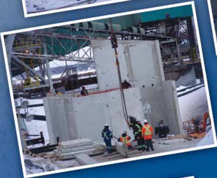
STRUTURE PRÉFABRIQUÉE POSTE DE POMPAGE, MINE WABUSH - DIVISION POINTE-NOIRE, SEPT-ÎLES
