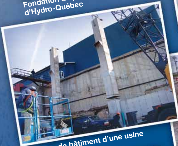
Ponceaux rectangulaires km 38 route 389
